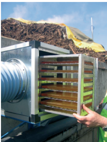
Zdj. 5. Płytki żelowe IDRAGEL. Wspomaganie dezodoryzacji biofiltrów
