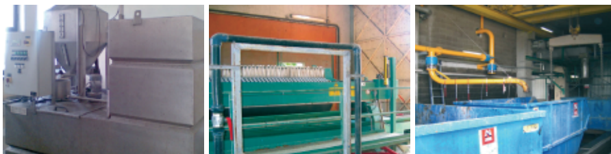
Zdj. 4. Bariera płytek żelowych IDRAGEL. Dezodoryzacja składowiska osadów
