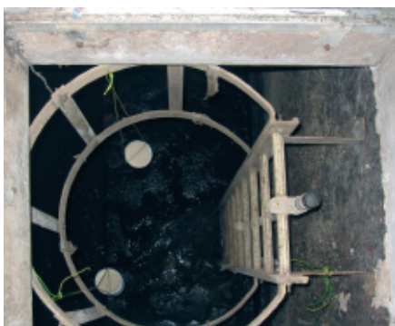
Zdj. 6. i Rys. 1. Dezodoryzacja studzienek kanalizacyjnych, puszki z żelom AIRHITONE NVG
